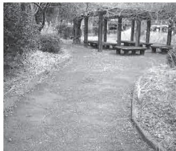
藤棚散歩道整備
